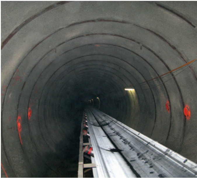
Ruban transporteur acheminant les matériaux d'excavation de Moutier à Court, via la galerie de reconnaissance du tunnel du Graitery, en vue de leur entreposage définitif sur le site de Chaluet, à l'Est de Court (ci-dessous).
