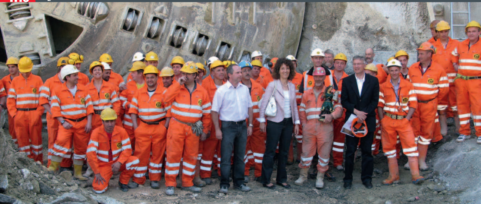
8 mai 2008 : la sortie du tunnelier, en présence de la Directrice des travaux publics, des transports et de l'énergie du canton de Berne Madame Barbara Egger-Jenzer.
