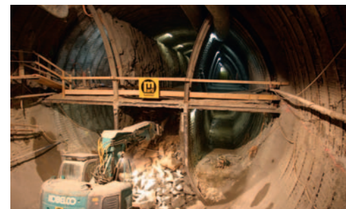
Les zones à marnes tectonisées ont été excavées en six parties (section divisée).
