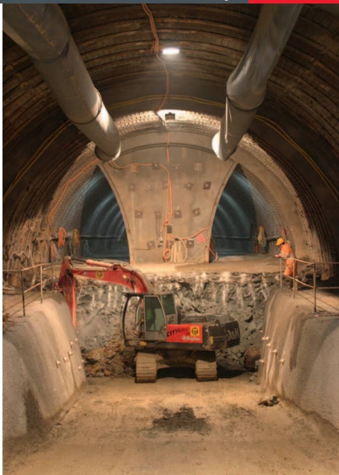
Les zones à marnes tectonisées ont été excavées en six parties (section divisée).
