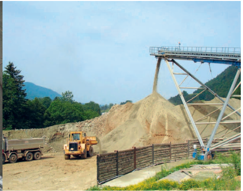
Ruban transporteur acheminant les matériaux d'excavation de Moutier à Court, via la galerie de reconnaissance du tunnel du Graitery, en vue de leur entreposage définitif sur le site de Chaluet, à l'Est de Court (ci-dessous).
