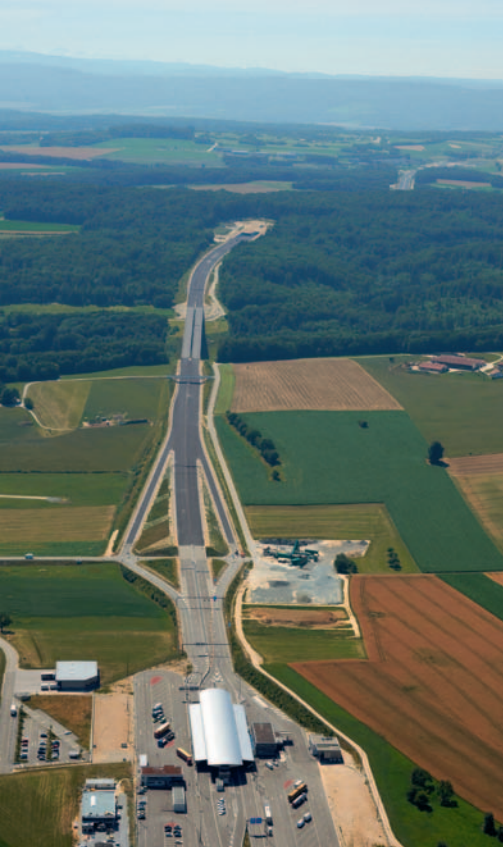
Vue générale de la section 2A Boncourt – Bure. Au premier plan, la plate-forme douanière de Boncourt-Delle et la jonction de Boncourt. A l'arrière-plan, sur la droite, on distingue la jonction de Bure, à proximité de la Place d'armes fédérale.
