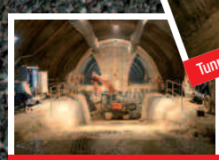
Tunnel de Moutier, section divisée
