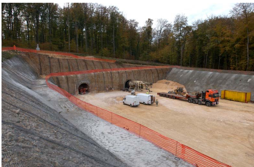
Tunnel de Neu-Bois, portail Nord, Boncourt (31.10.06)
