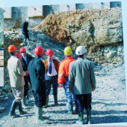
Porrentruy, portail ouest du tunnel du Banné, sous la conduite de Roger Chèvre, responsable de la Direction locale des travaux Perche+Banné.
