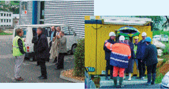
Après une séance au pavillon de Moutier, c'est le départ pour la visite des chantiers du tunnel du Raimeux, sous la conduite d'Etienne Aubry, responsable de la Direction des travaux A16 à Moutier ... ... avec une halte au local d'équipement (casque obligatoire, parapluie facultatif !)
