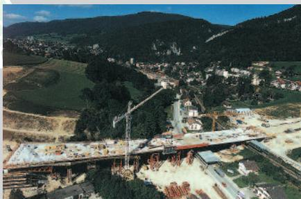
Avant sa mise en service, ce viaduc sera utilisé dès l'an prochain comme piste de chantier pour l'acheminement des matériaux excavés du tunnel du Raimeux. La largeur du viaduc varie car il contient en partie les pistes d'accélération / décélération de la jonction Moutier Nord.
