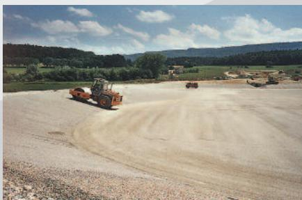
Ces bassins, étanches, remplissent plusieurs fonctions : rétention d'une pollution accidentelle massive sur l'A16 ; dilution d'une faible pollution ; laminage des crues ; décantation des matières en suspension ; biotope pour bactériens ; espace végétalisé avec fonction ludique.
