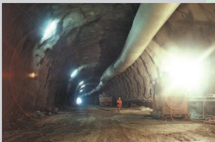
L'excavation en pleine section des 2 tubes du tunnel de la Perche s'est terminée à fin octobre 2000. L'excavation de la galerie technique est en cours. Puis suivront les étapes de bétonnage de la voûte et de la galerie technique ainsi que la réalisation des portails. Quant au tunnel du Banné, l'excavation a débuté en novembre 2000.
