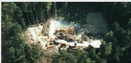
Le puits de ventilation se trouve à 1 km environ au sud du portail nord du tunnel du Raimeux, sur les hauts de Roches, à 10 m à l'ouest du tracé de la Transjurane. Le creusement, de haut en bas, s'effectue par minage et par attaque ponctuelle. Sa fonction, comme son nom l'indique, sera d'aspirer (naturellement ou à l'aide de ventilateurs) l'air vicié ou les fumées émises à l'intérieur du tunnel.
