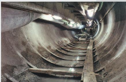
Phase d'excavation terminée à mi-octobre 2000, à 2960 m à partir du portail sud. Un puits de 25 m de profondeur et de 1 m de diamètre a été foré au mètre 2928. Il permet un accès à la galerie depuis le nord pour divers contrôles. Prochaines étapes : démontage et sortie du petit tunnelier. Aménagements intérieurs. Géologie : les sondages ont révélé un sous-sol moins aquifère que prévu. Plusieurs réseaux karstiques ont été mis à jour lors du percement de la galerie.
