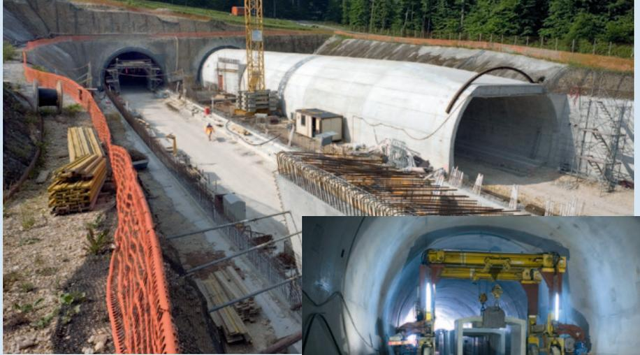
▲ Tunnel du Neu-Bois, portail nord / ► Mise en place des éléments préfabriqués de la gaine technique.
