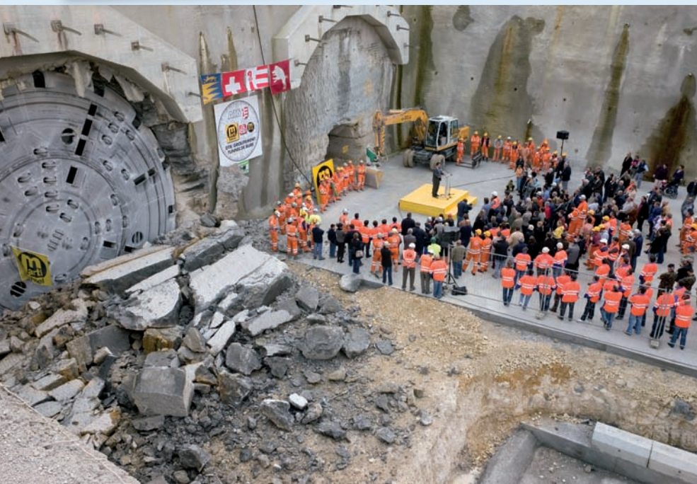
Manifestation du percement du tunnel de Bure, portail nord, 15.10.2008
