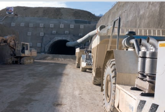
2 5 Tunnel du Bois de Montaigne, portail est
