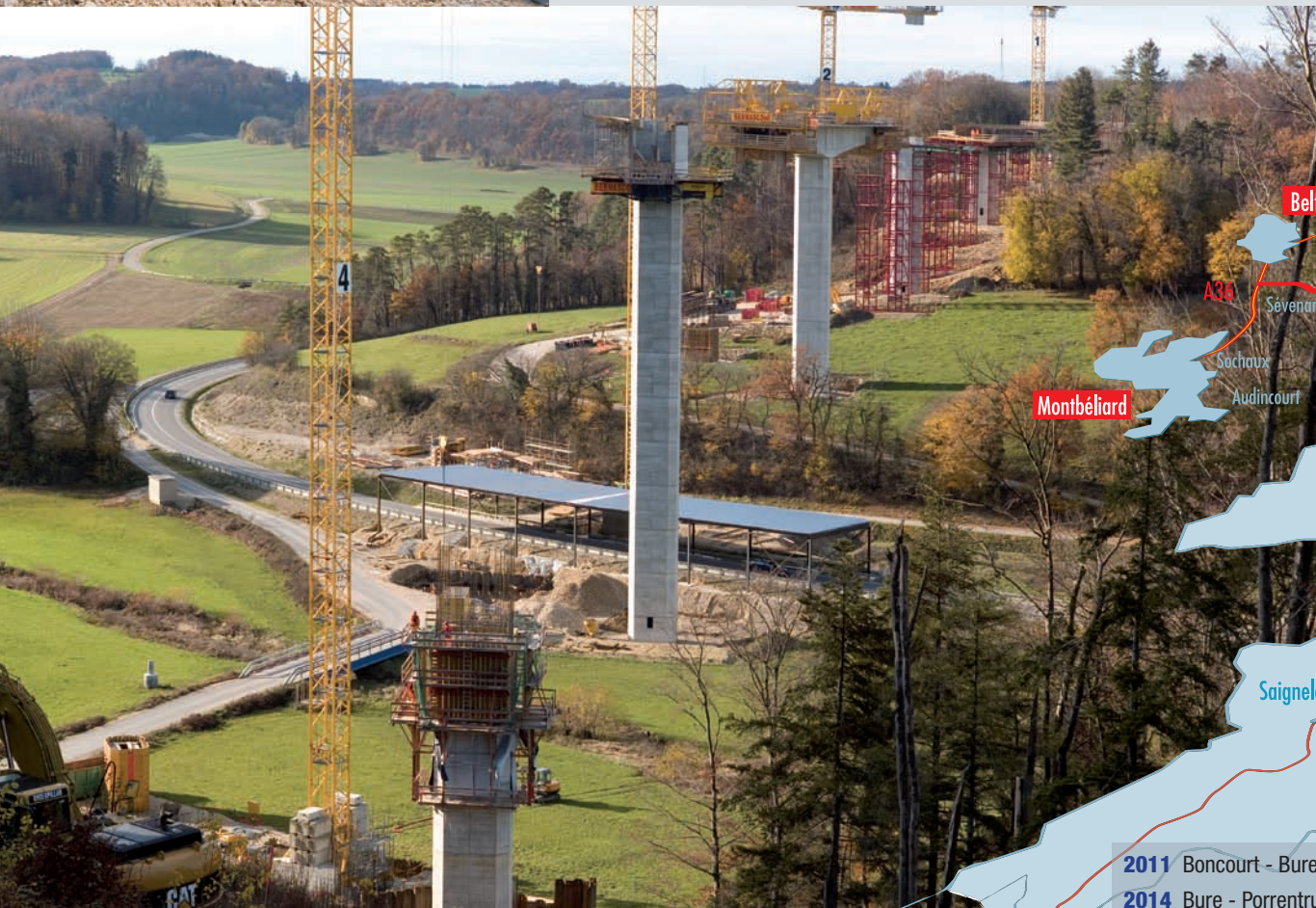
4 Viaducs du Creugenat
