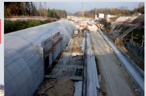
1 Tunnel du Neu-Bois, portail nord
