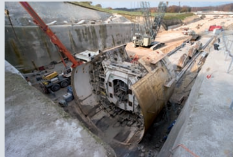
2 Tunnel de Bure, portail nord
