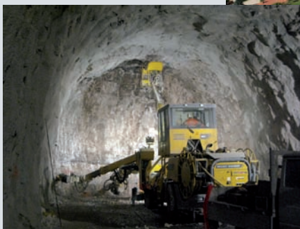
8 Tunnel du Graitrey
