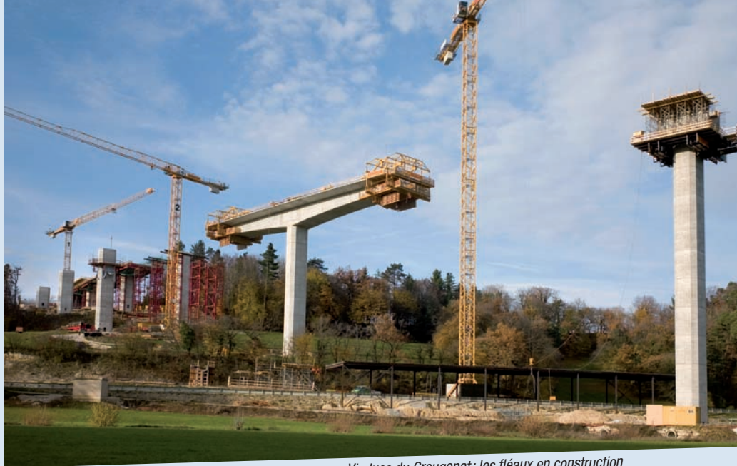
Viaducs du Creugenat: les fléaux en construction
