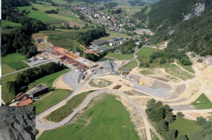
9 Viaduc de Chaluet et jonction de Court
