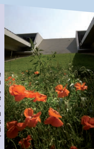
Tunnel de la Perche, portail ouest, Porrentruy
