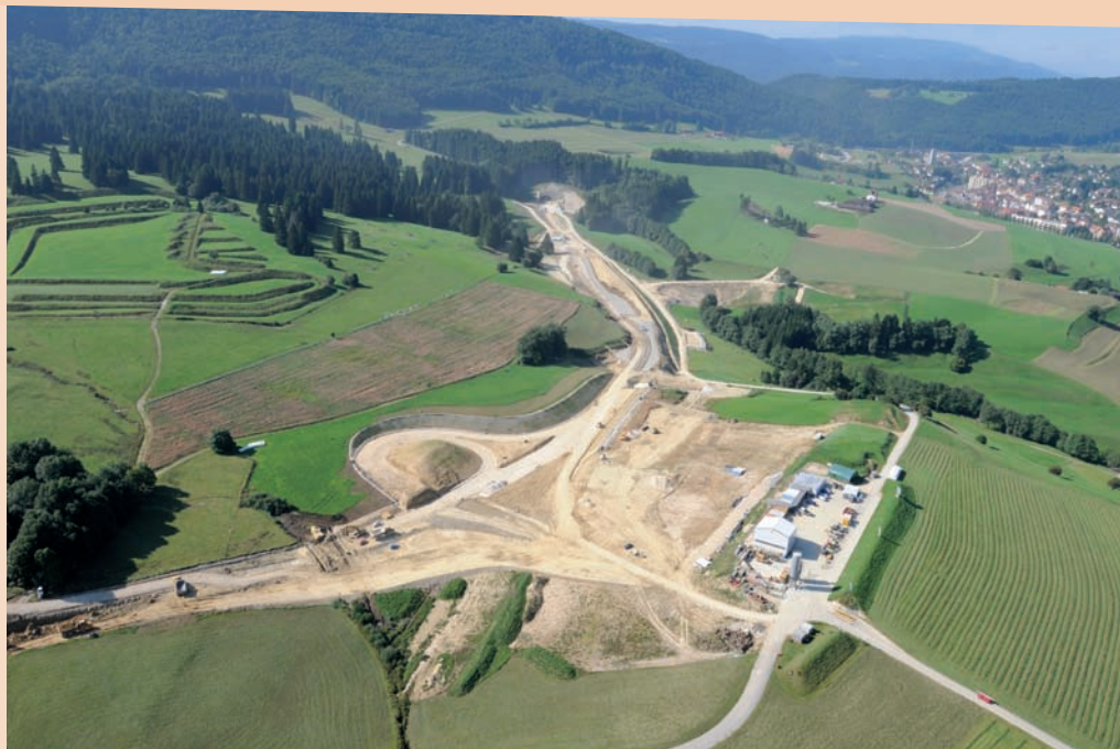
Future aire de repos de Reconvilier
