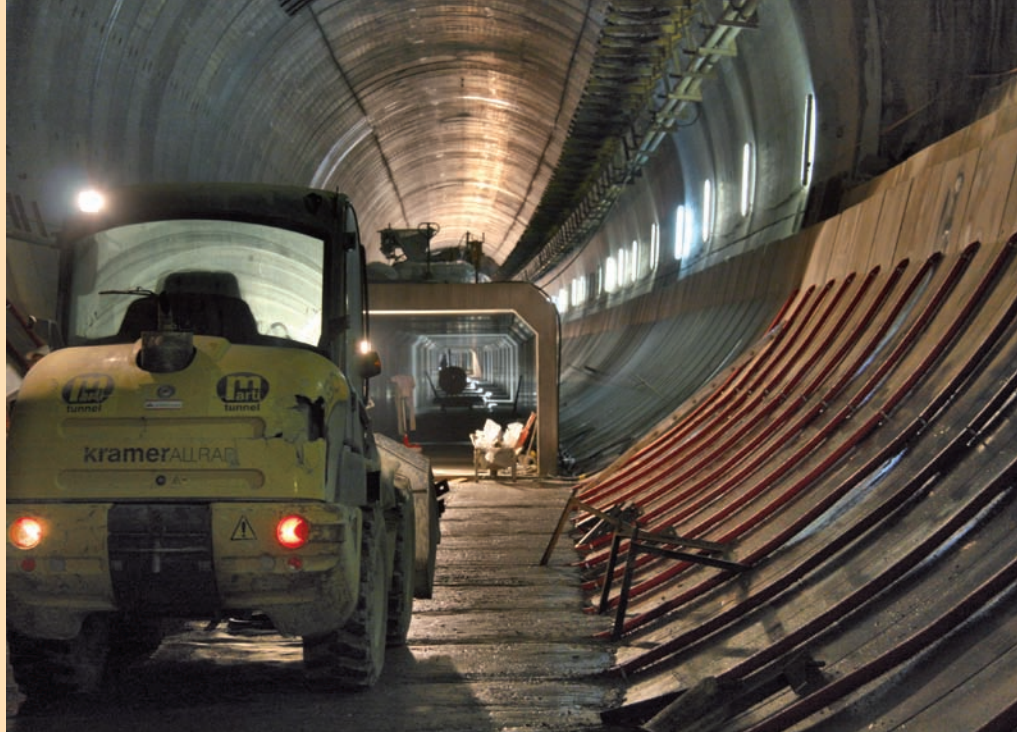
Tunnel de Moutier, tube aval : pose des éléments de la GAT
