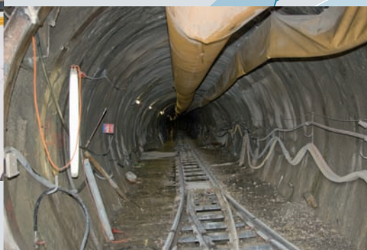
6 Galerie de reconnaissance du tunnel de Choindex
