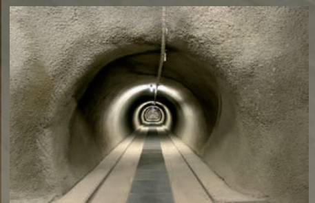
Galerie de sécurité
