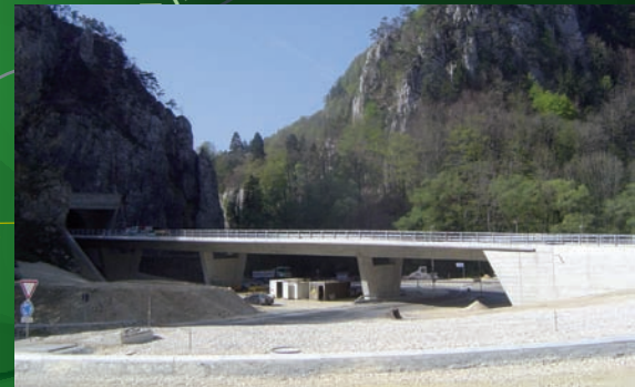
2 Viaduc de la Verrerie
