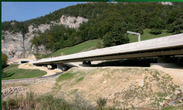
5 Viaduc de la Combe Chopin
