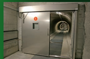
7 Tunnel du Raimeux, galerie de sécurité
