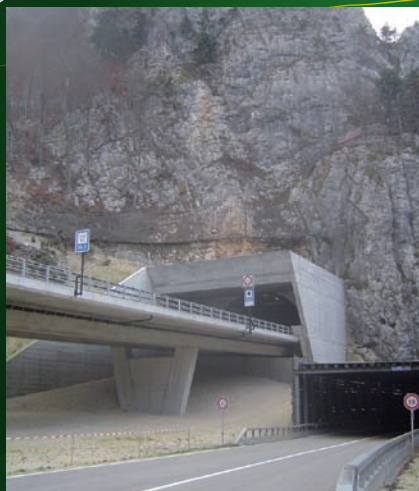
3 Tunnel de la Roche St-Jean, portail Nord
