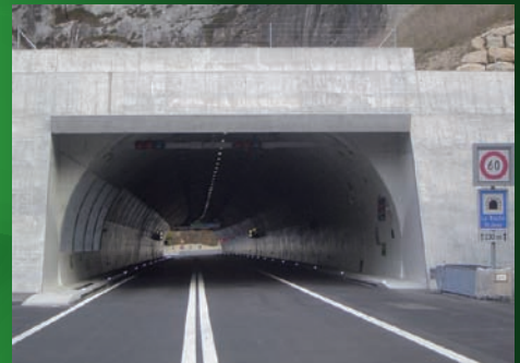
4 Tunnel de la Roche St-Jean, portail Sud
