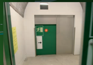
Tunnel du Raimeux, galerie de liaison (tous les 300 m)
