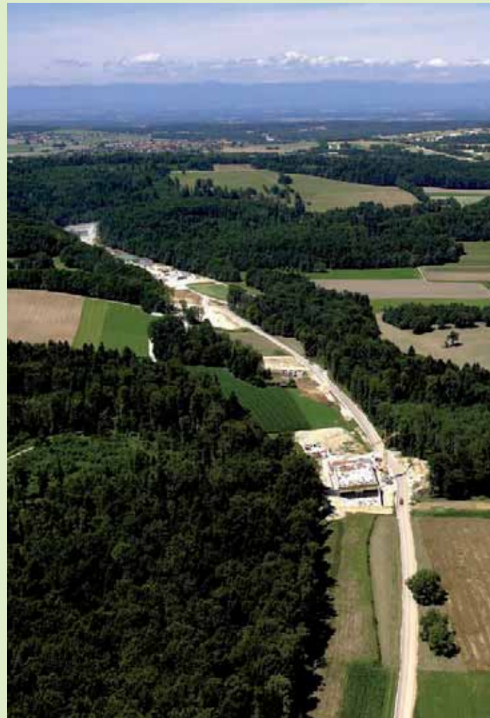
Réseau de pistes de chantier le long du tracé de la section 2, de Boncourt à Porrentruy (ici : Courtedoux).
