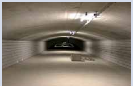
Dalle de ventilation située au-dessus de l'espace trafic.
