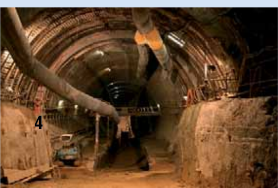
Tube aval: démontage des cintres de la section divisée.
