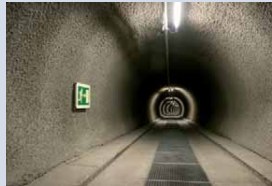
Galerie de secours sur toute la longueur du tunnel.
