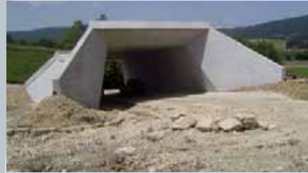
PI Sous le Mont : passage inférieur combiné avec un ruisseau (longueur : 34 m).
