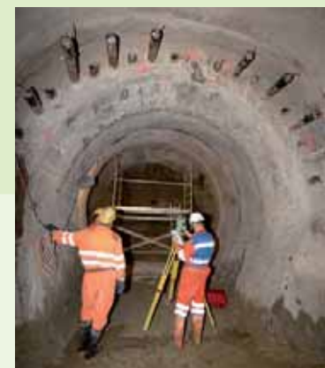
Galerie de reconnaissance du tunnel de Choindez, en construction depuis octobre 2006.
