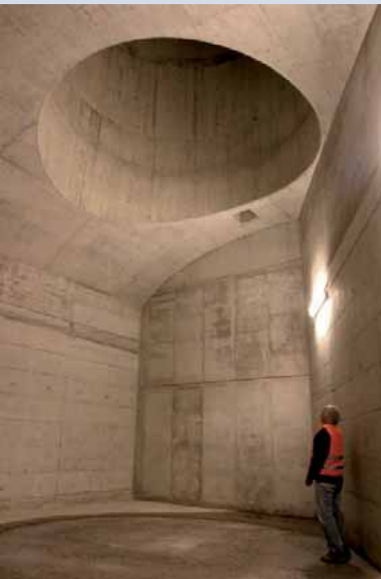
Tunnel du Raimeux, puits de ventilation.
