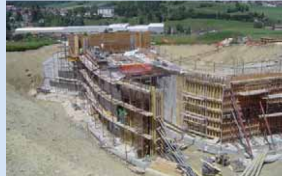
PI La Charbonnière : passage inférieur routier (longueur : 22.5 m).
