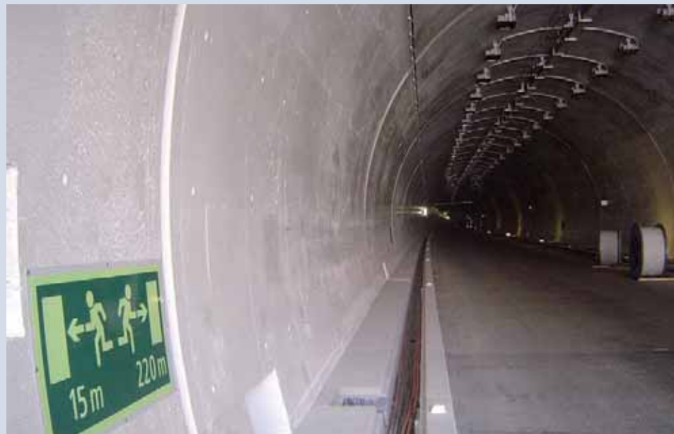
Dalle de ventilation située au-dessus de l'espace trafic.
