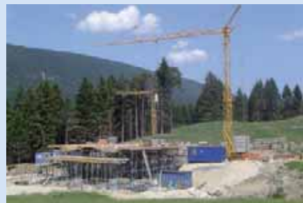
PI Jonction de Loveresse : passage inférieur routier (longueur : 21 m).
