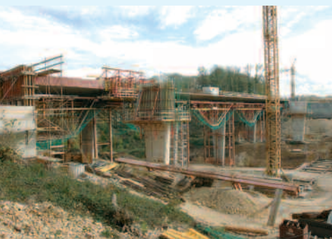
Viaducs de la Combe Baidère, au nord de la jonction de Bure.
