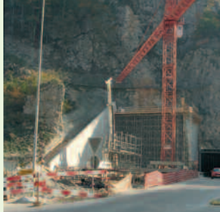
Tunnel de la Roche St-Jean, portail nord.
