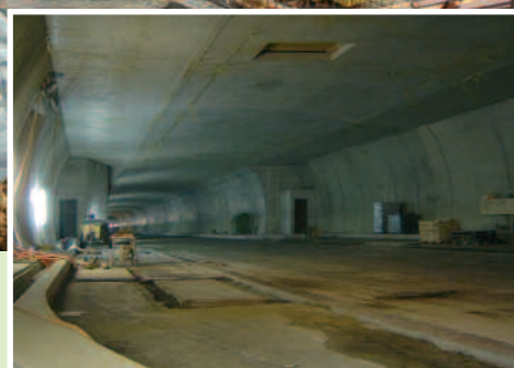
Tunnel du Raimeux: les travaux de gros-œuvre bientôt terminés.
