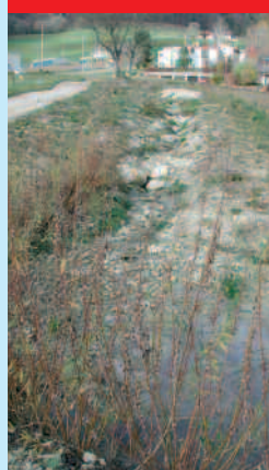
Etang forestier revitalisé et étanchéifié dans le cadre du projet d'aménagement du ruisseau de l'ancien stand de tir de Moutier.
