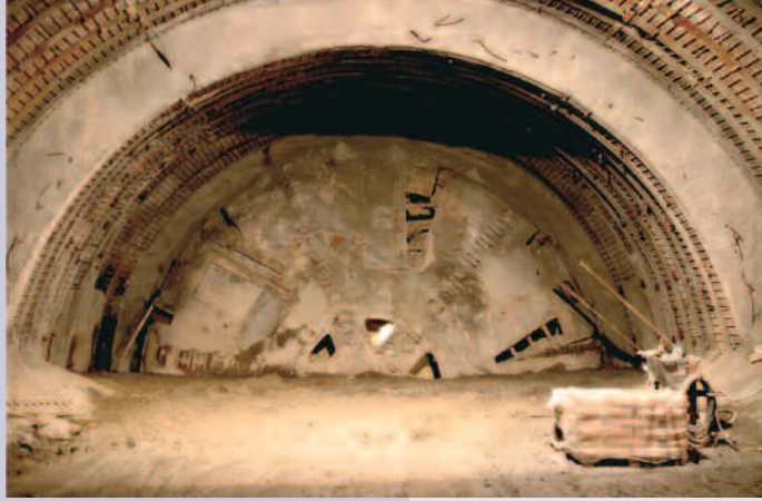
La tête du tunnelier est désormais accessible.
