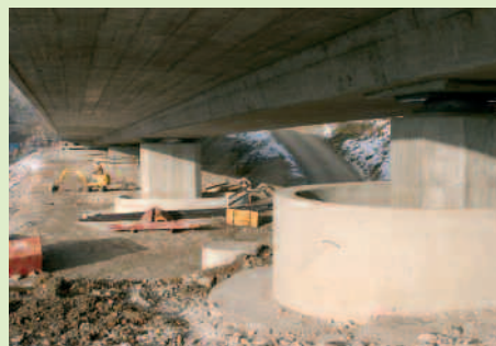
Viaduc de la Combe Chopin.
