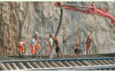
Tunnel de la Roche St-Jean, portail sud.
