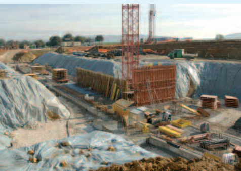
Plate-forme douanière de Boncourt: construction du passage inférieur piétons.
