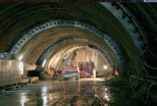
La première phase de l'excavation en méthode traditionnelle s'effectue en calotte (partie supérieure du tube).
