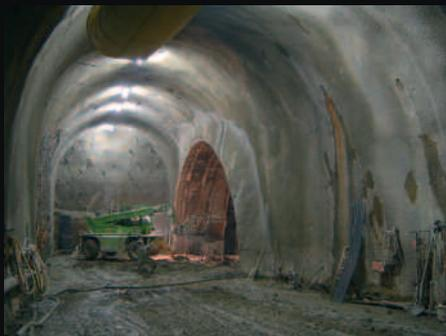
Galerie latérale entre les tubes amont et aval: calotte et stross sont excavés.
