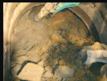
Les deux tubes du tunnel de Moutier traversent une zone géologique perturbée, dans laquelle la roche est très fracturée et localement aquifère.
