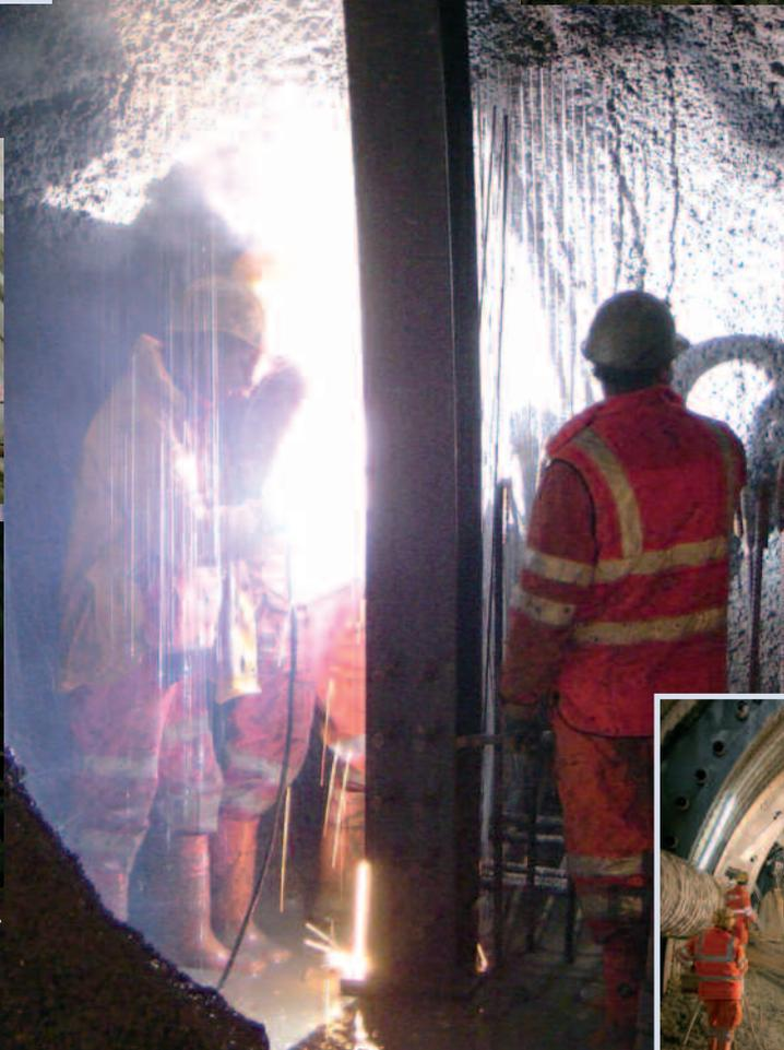
Excavation en méthode traditionnelle avec soutènement en voûte parapluie.
