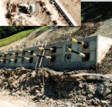
Dans le secteur de la Combe Chopin, entre les tunnels du Raimeux et de la Roche St-Jean, les glissements de terrain ont nécessité une consolidation supplémentaire de la pente.
