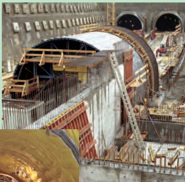
Tunnel du Banné, portail ouest : réalisation de la galerie couverte précédant l'entrée dans le tunnel proprement dit.
