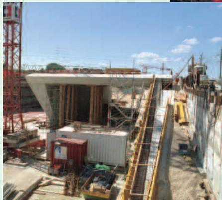
Passage supérieur de la Ballastière: l'A16 passera en 4 pistes sous la route cantonale Delémont-Courrendlin et sous la ligne CFF.
