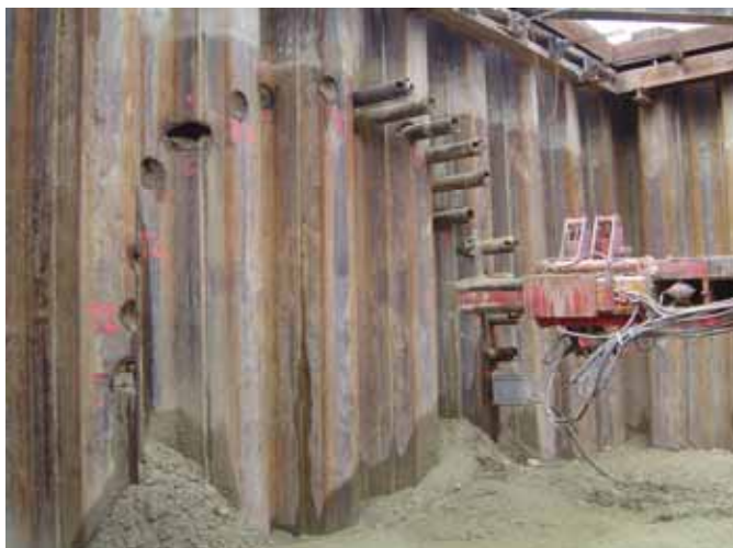
Les 25 premiers mètres de l'excavation permettant de passer sous la route cantonale Courrendlin-Vicques sont consolidés par un soutènement de voûtes parapluie.
