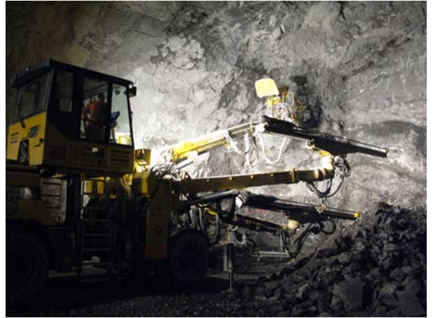
Excavation par minage (explosif) au moyen d'une foreuse «Jumbo» (7.05.2008).
