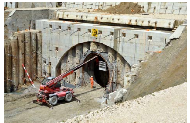
Portail sud: excavation des 50 derniers mètres du tunnel, en section divisée en raison de la nature très instable de la roche (31.05.2010).
