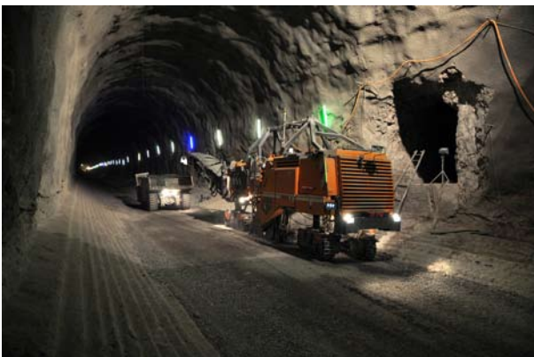
Excavation par fraisage de la partie inférieure du tunnel (15.06.2010).
