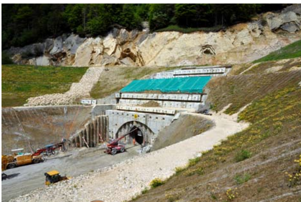
Portail sud: excavation des 50 derniers mètres du tunnel, en section divisée en raison de la nature très instable de la roche (31.05.2010).
