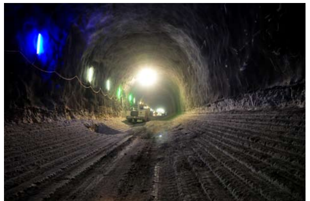
Excavation par fraisage de la partie inférieure du tunnel (15.06.2010).
