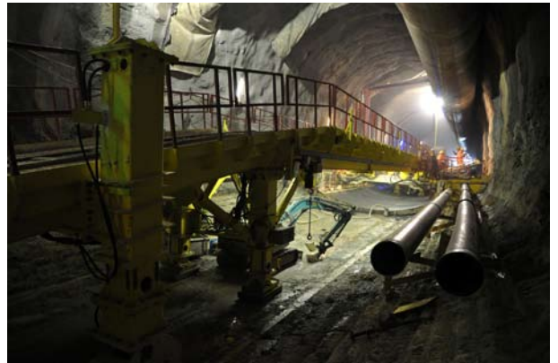
Pont amovible permettant le franchissement de l'atelier de bétonnage du radier (8.02.2010).
