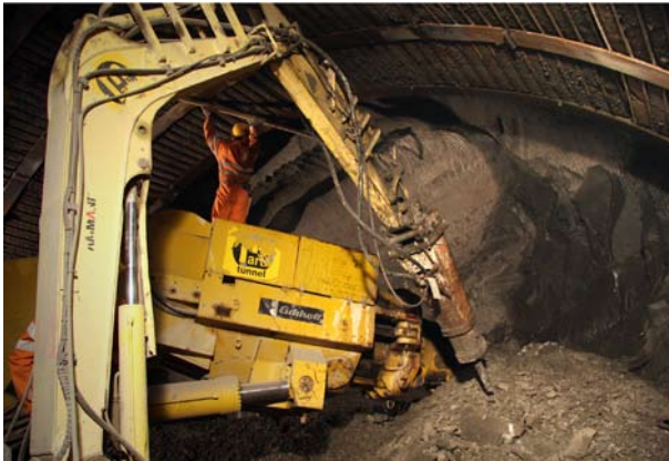
Soutènement de la calotte et excavation à la haveuse (31.03.2009).
