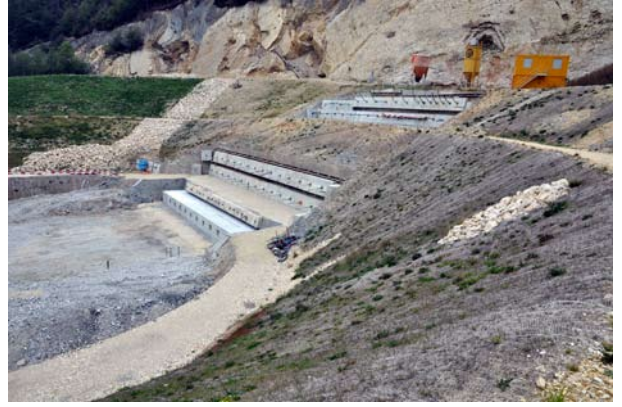
Portail sud: la zone du portail est stabilisée au moyen notamment de longrines en béton (16.09.2009).
