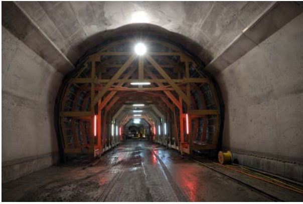
Bétonnage de la voûte intérieure du tunnel, avec de part et d'autre les appuis de la future dalle de ventilation, exécutée ultérieurement (15.06.2010).
