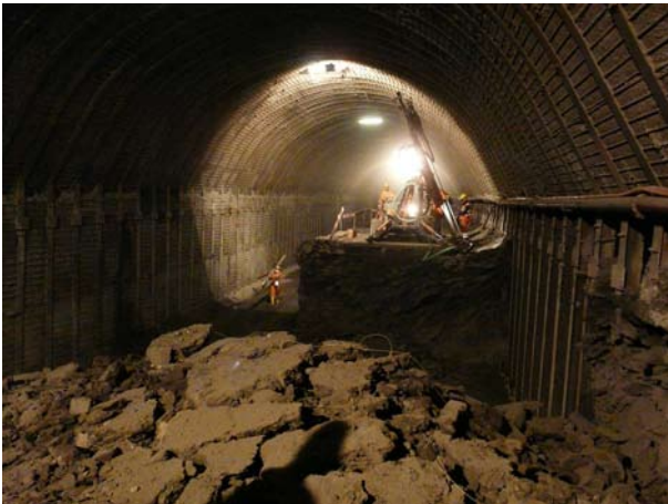
Excavation par minage de la partie intermédiaire ou «stross» du tunnel (23.02.2010).
