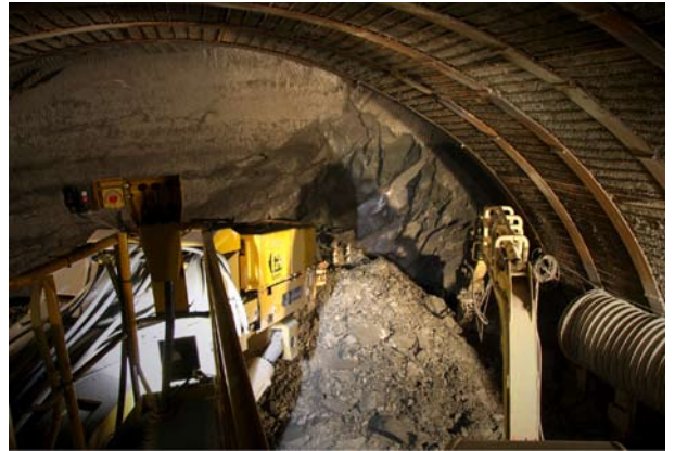
Soutènement de la calotte et excavation à la haveuse (31.03.2009).
