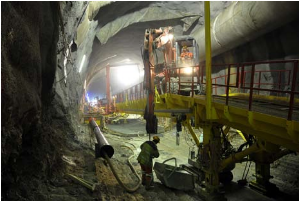
Pont amovible permettant le franchissement de l'atelier de bétonnage du radier (8.02.2010).
