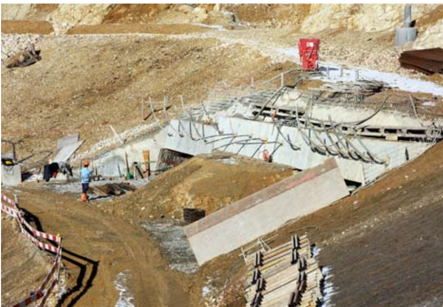
Importants travaux de stabilisation au portail sud, à Court (3.02.2009).
