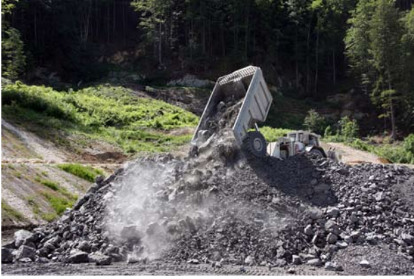
Portail nord: marinage et évacuation des matériaux d'excavation au moyen de «dumpers» d'une contenance de 23 m 3 (31.05.2009).
