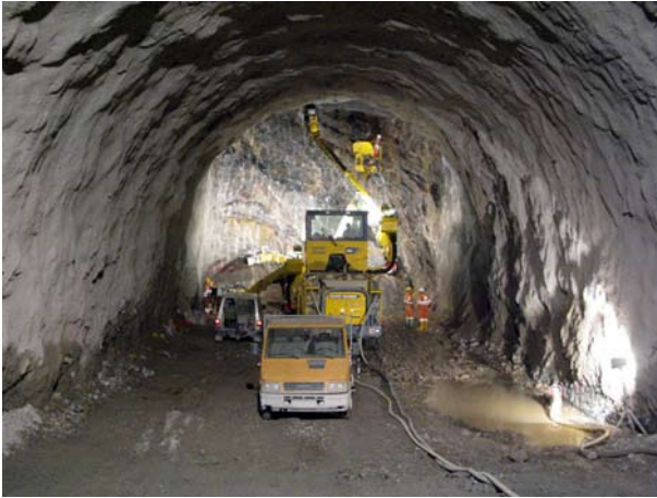
Excavation par minage (explosif) au moyen d'une foreuse «Jumbo» (7.05.2008).
