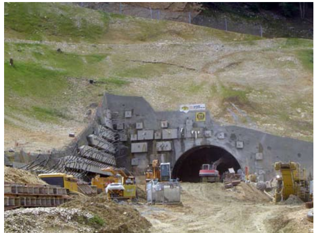
Portail nord: réalisation du soutènement «voûte parapluie» (10.07.2007).
