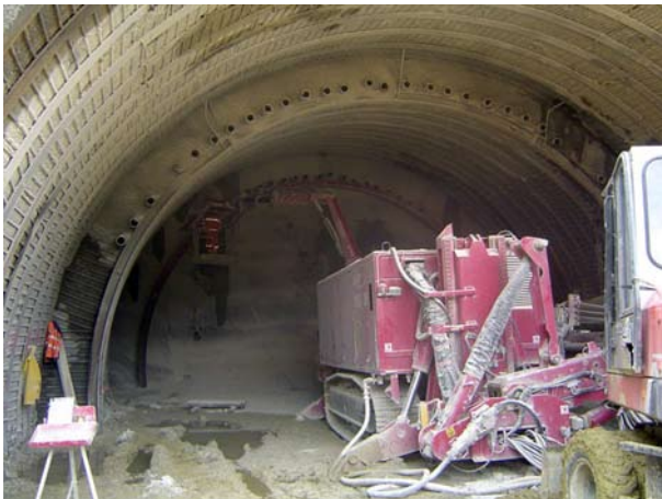
Portail nord: réalisation du soutènement «voûte parapluie» (10.07.2007).
