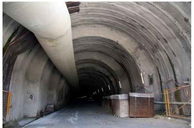
Portail nord: soutènement (8.09.2008).
