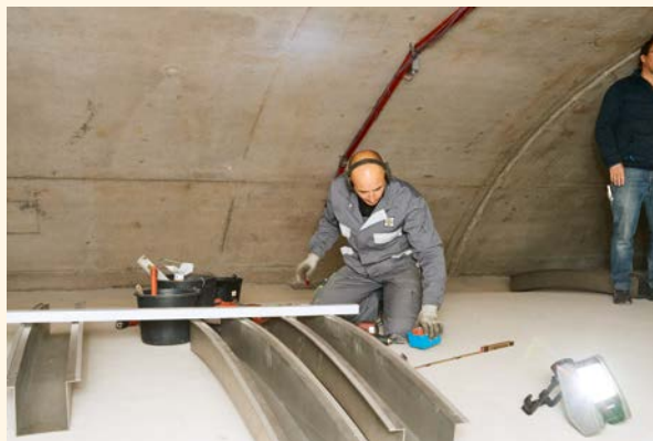
Le serrurier s'apprête à protéger l'instrumentation à l'aide de capots.
