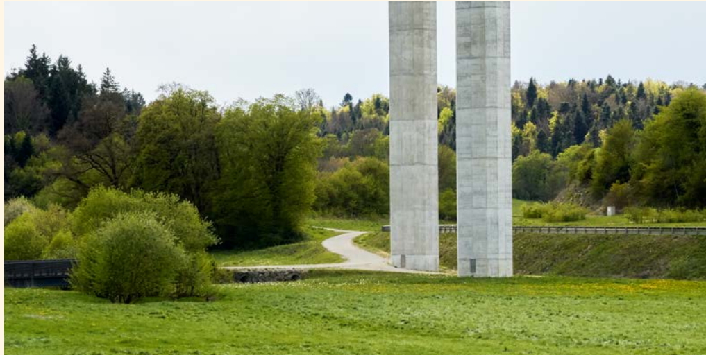
Vue sur les piles des viaducs et leurs portes d'accès.
