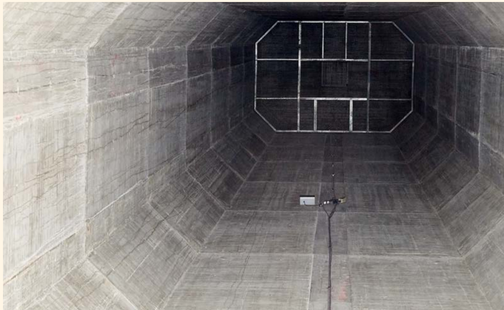
Vue de l'intérieur d'une pile.
